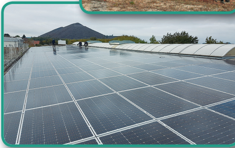
Panneaux solaires installés sur le centre technique municipal à l'automne 2019.
